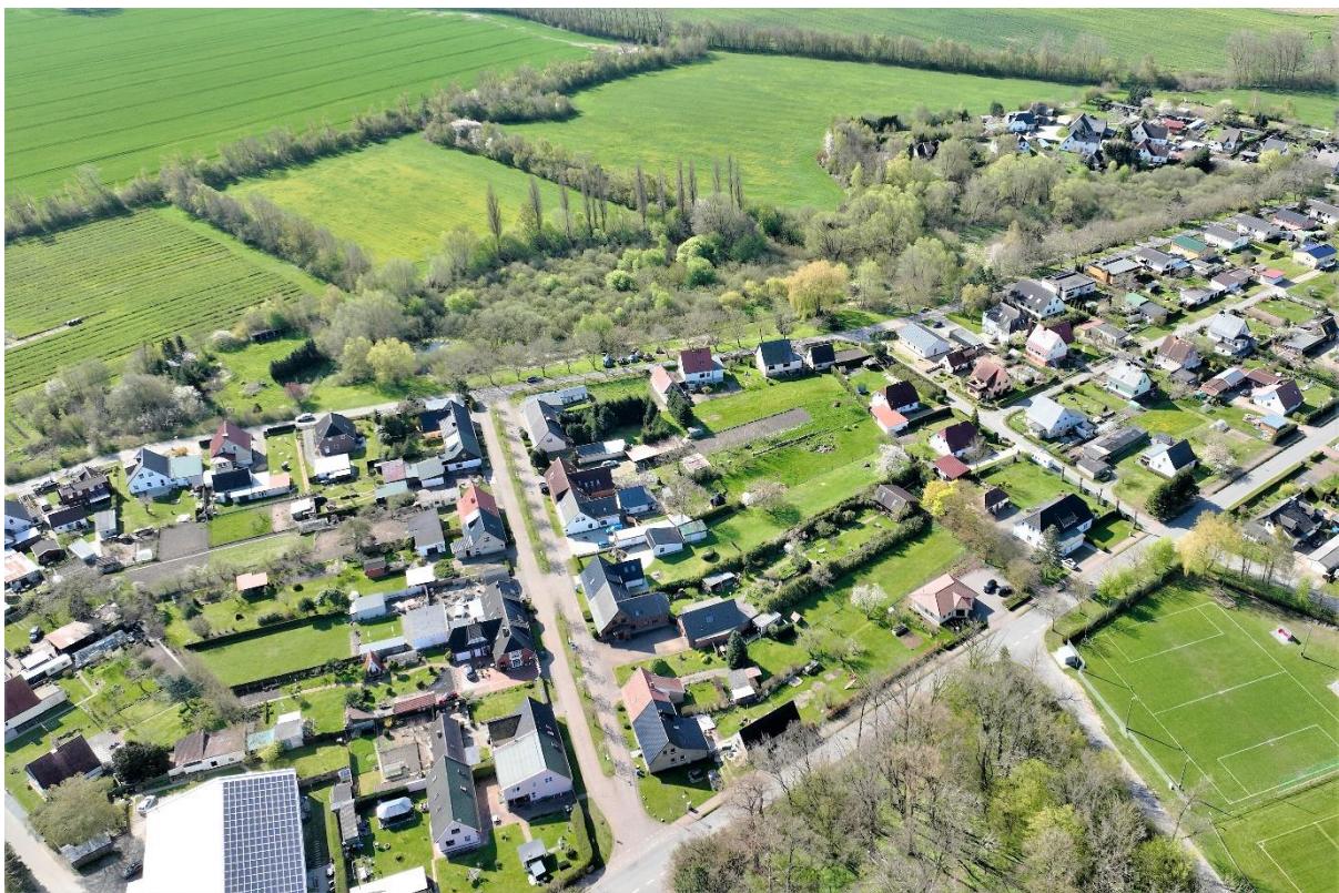
Luftbild zur Lage in Trinwillershagen
